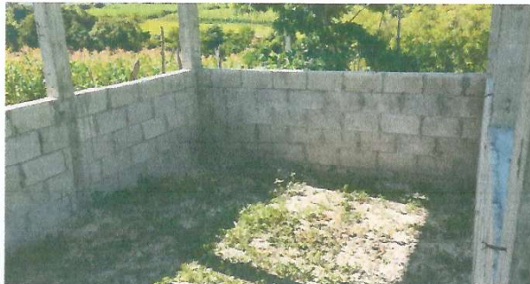
Foto 3: Mejoramiento de losa de piso en la cocina.
