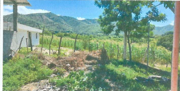
Foto 2: Mejoramiento del muro perimetral del lado este del instituto.
