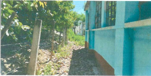
Foto 1: Mejoramiento del muro perimetral del lado norte del instituto.
